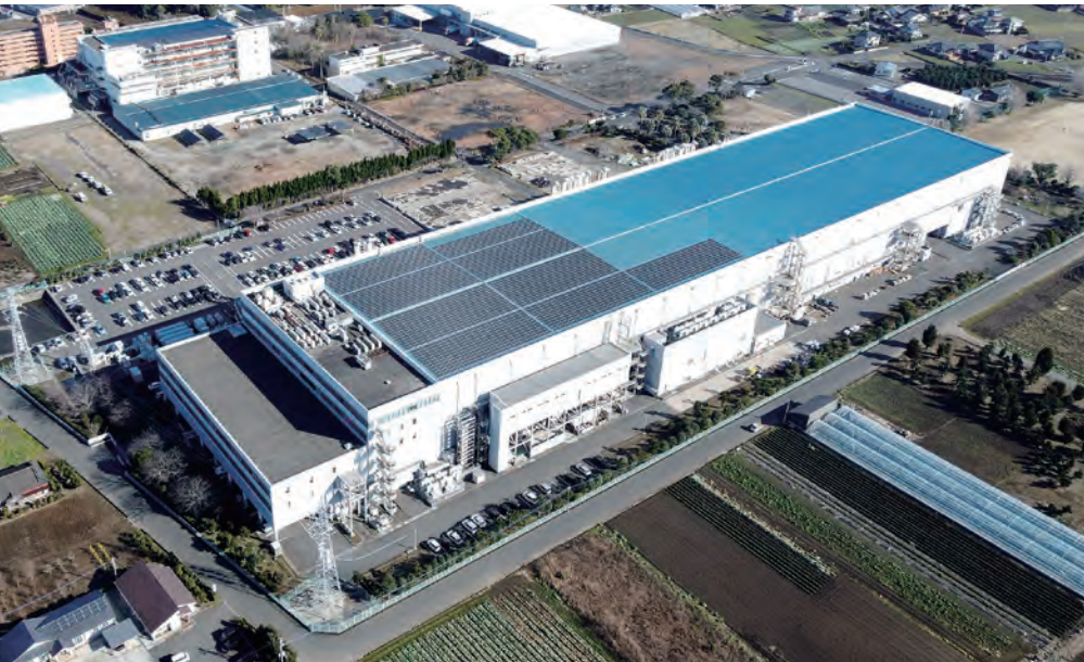
出水事業所と建設予定地（鹿児島県出水市）
